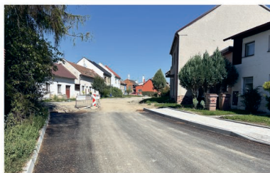
Rekonstrukce ulice Staromajetinská
