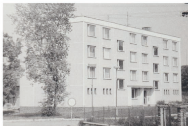
Panelový dům č. 13
