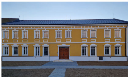
Budova Komunitního centra
