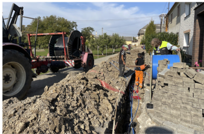
Realizace optických rozvodů
