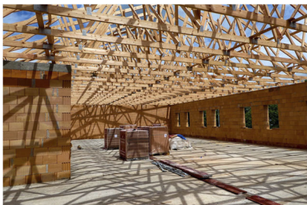
Výstavba Komunitního centra
