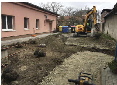
Stavební úpravy ve dvoře OÚ
