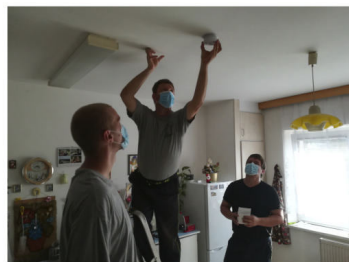
Montáž detektorů kouře v DPS
