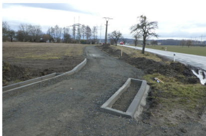
Stavba cyklostezky Majetín-Krčmaň
