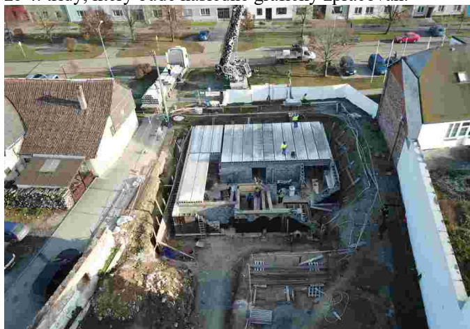
Stavba Komunitního centra
