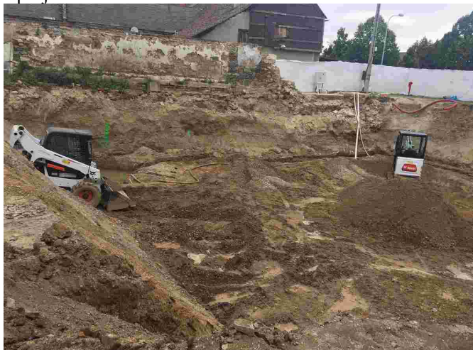
Zahájení stavby Komunitního centra
