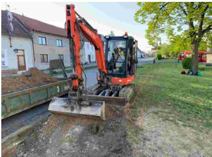
Výstavba parkovací plochy
