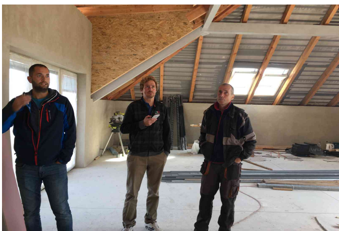
Kontrolní den stavebních prací ve škole
