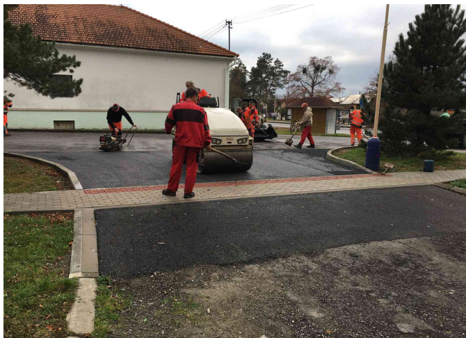
Rekonstrukce chodníků v ul. Za Humny
