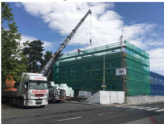
Rekonstrukce budovy ZŠ a MŠ
