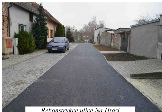
Rekonstrukce ulice Na Hrázi
