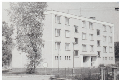
Panelový dům č. 13
