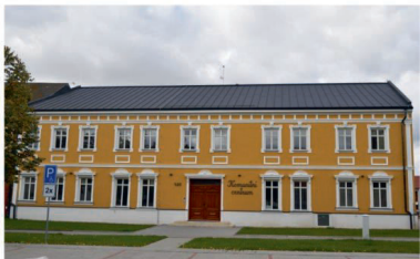
Budova komunitního centra
