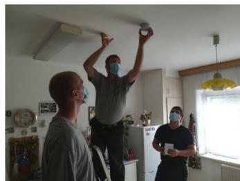
Montáž detektorů kouře v DPS
