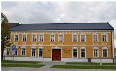
Budova komunitního centra
