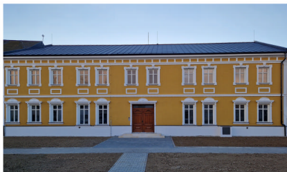
Budova Komunitního centra
