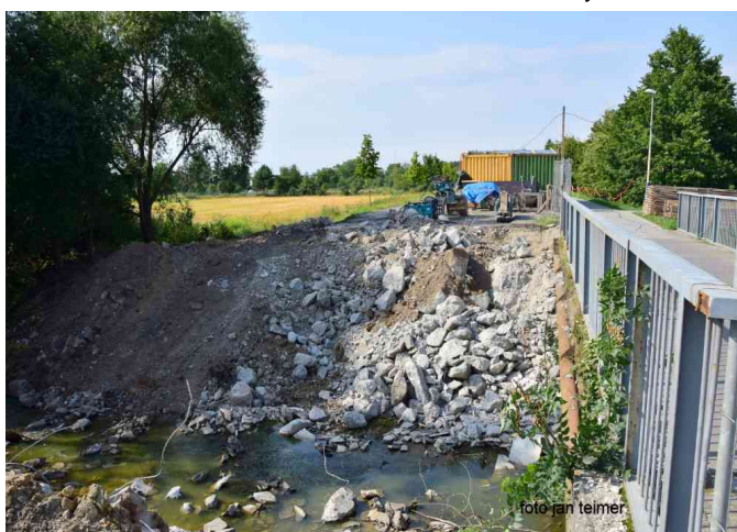
Demolice starého mostu přes Olešnici
