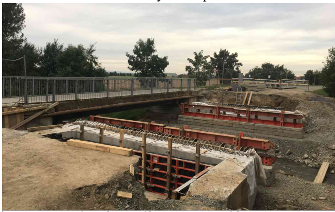
Výstavba nového mostu přes Olešnici
