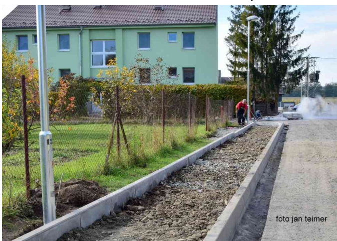
Výstavba chodníků v ul. Příhon
