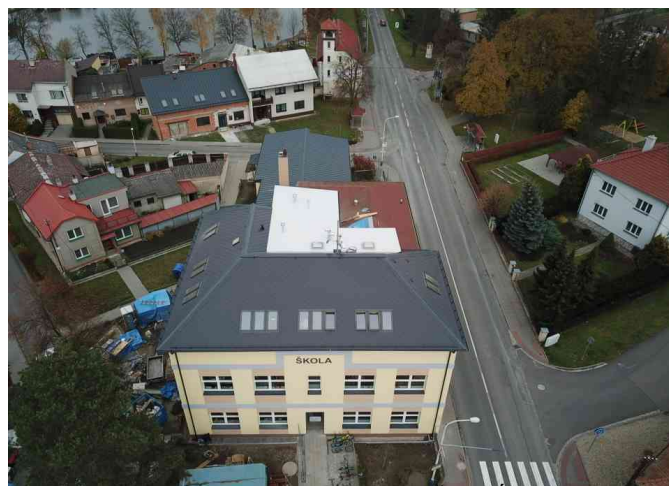
Rekonstrukce budovy ZŠ a MŠ
