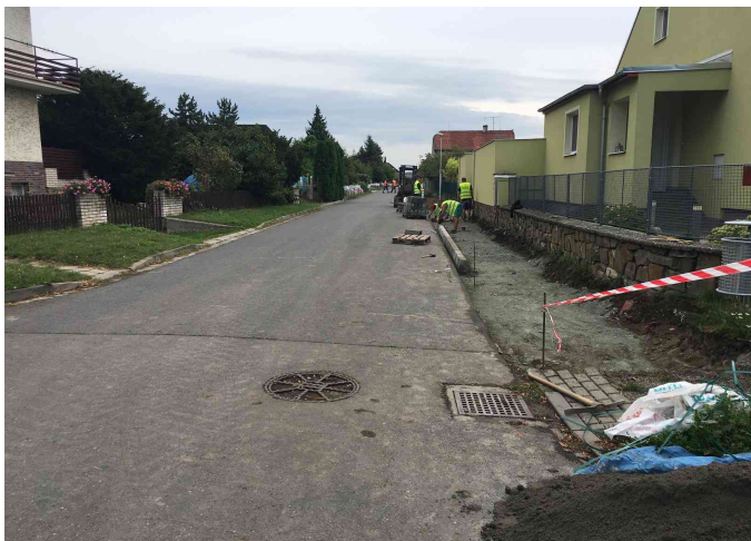
Rekonstrukce chodníků v ul. Za Humny
