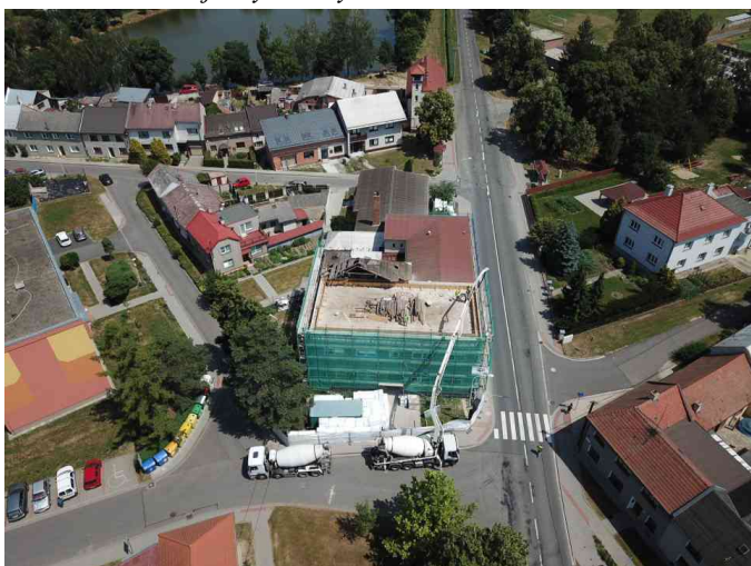
Rekonstrukce budovy ZŠ a MŠ
