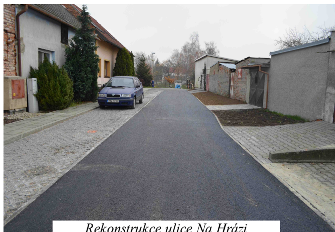
Rekonstrukce ulice Na Hrázi
